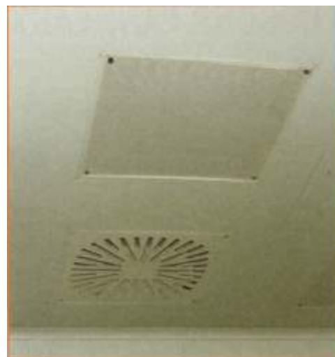
Sufit pomieszczenia czystego zlicowany
