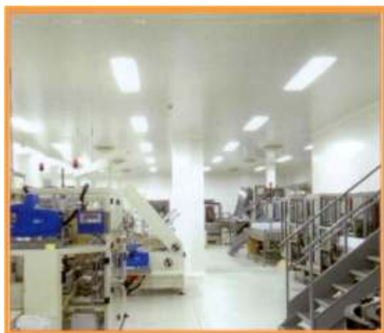
Sufit typu przemysłowego
